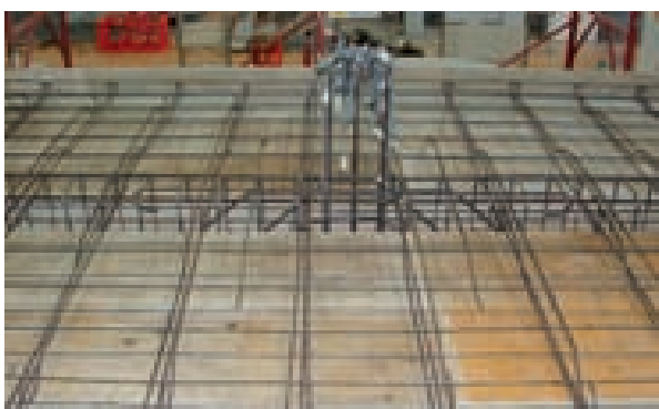
Figura 7. Armatura dell'impalcato
