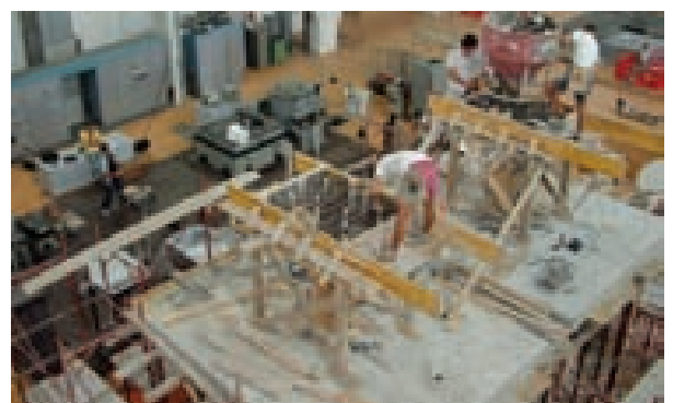
Figura 8. Il getto di calcestruzzo.
