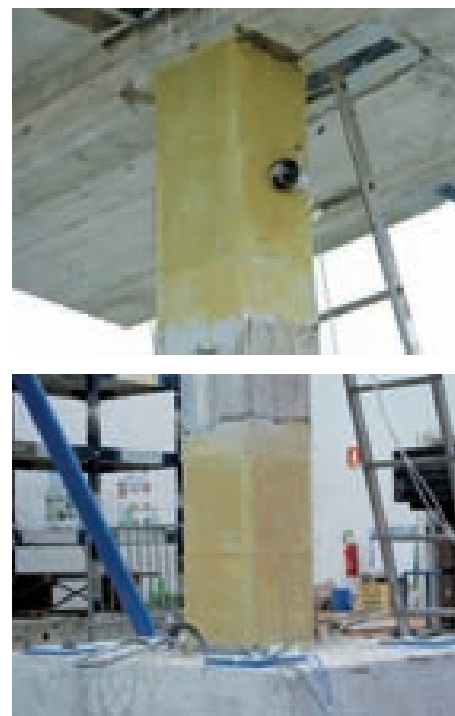
Figura 20. Il secondo intervento di rinforzo
